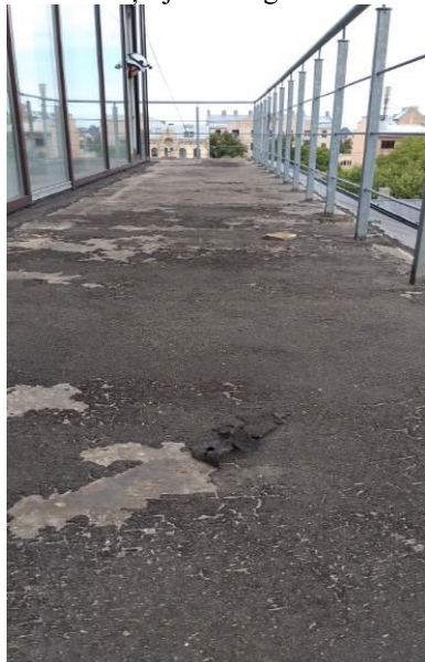
4.8.2.4., 4.8.2.5.att. Jaunizbūvētās daļas savietotā jumta segums ir pilnībā bojāts, atsegta betona kārta
