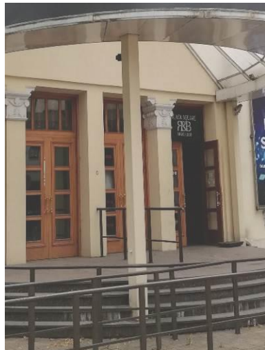
4.3.1.3.att. ieejas mezgla metāla kvadrātveida kolonnas balsta ieejas mezgla jumtu.
