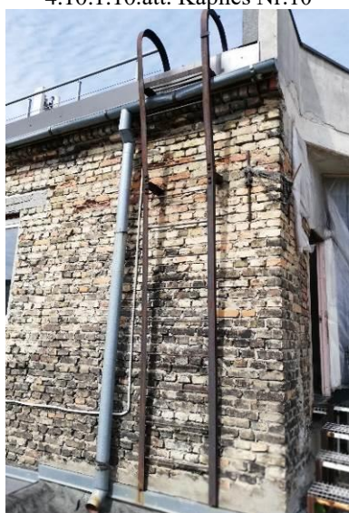
4.10.1.12.att. Metāla kāpnes nokļūšanai uz jumta.
