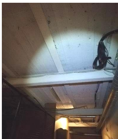
4.6.2.3.att. Metāla siju pārsegums ar monolītbetona aizpildījumu.
