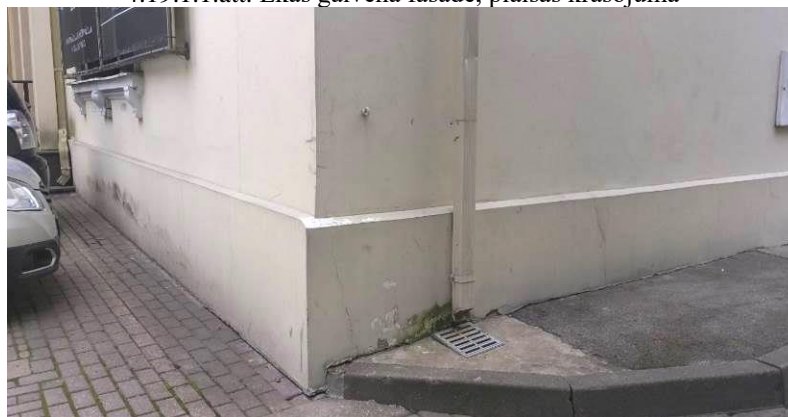
4.19.1.2.att. Mikroplaisu tīkls apdares krāsojumā un apmetumā
