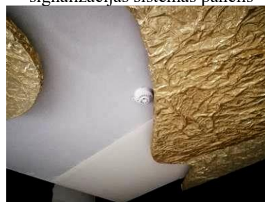
5.3.4. att. Automātiskās ugunsgrēka atklāšanas un trauksmes signalizācijas sistēmas ugunsgrēka detektors
