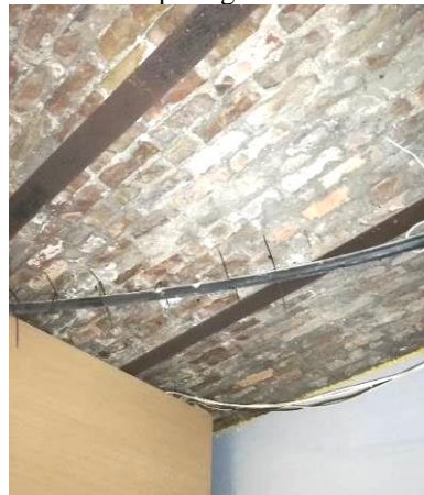
4.6.2.6.att. Metāla siju pārsegumi ar ķieģeļu velvju aizpildījumu.
