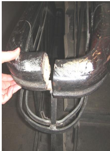
4.10.1.1.att. Kāpnes Nr.10, trūkst vertikālie spraišļi, lietošanas drošības risks.
