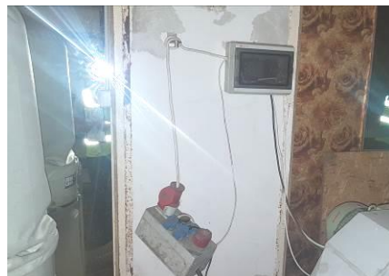
5.9.11. att. Nenostiprināta elektrosadalne, 1.stāva kluba telpas
