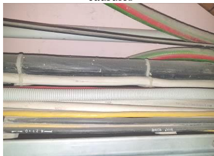
5.9.22. att. Komunikācijas, ugunsdrošības kabeļi un ūdensapgādes komunikācijas stiprināti kopā
