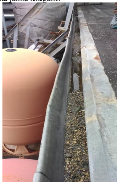
4.8.2.12.att. Nekvalitatīvi ierīkotas un piesārņotas renes, netiek nodrošināta ūdens novadīšana
