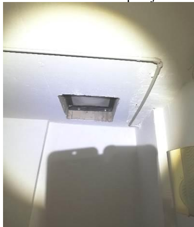
4.6.2.5.att. Pārsegumā izkalts atvērums un tajā iebūvēta lūka.
