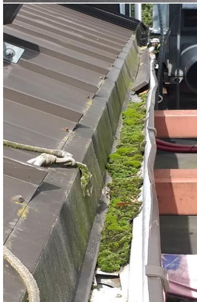
4.8.2.15., 4.8.2.16., 4.8.2.17., 4.8.2.18.att. Apsūnojis jumta segums un ar sūnām un gružiem aizsērējušas notekrenes
