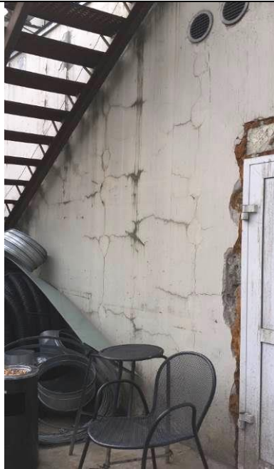
4.19.1.5., 4.19.1.6.att. fasādes apmetuma un krāsojuma bojājumi
