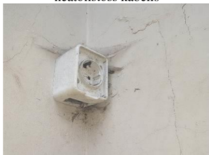
6.7.5. att. Kontaktligzda ārpus telpām bez atbilstošas IP klases, nav aizsargvāka
