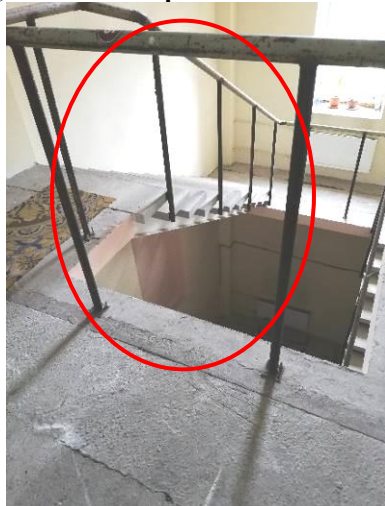
4.10.1.1.att. Kāpnes Nr.10, trūkst vertikālie spraišļi, lietošanas drošības risks.
