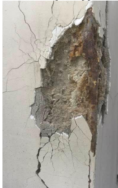
4.19.1.7., 4.19.1.8.att. fasādes apmetuma un krāsojuma bojājumi
