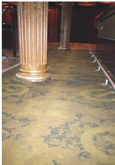
4.12.1.6.att. Nolietojies mīksta segums
