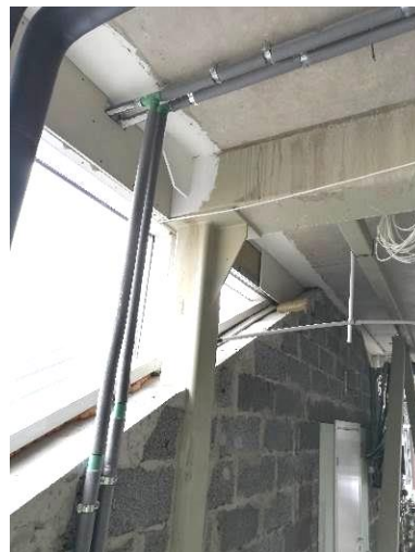
4.3.1.4.att. metāla cilindriskās kolonnas balsta pārsegumu ēkas iekšpagalmā (d=25cm). Nav pabeigta apdare.
