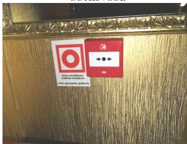
5.3.22. att. Dūmu novadīšanas sistēmas manuālā iedarbināšanas ierīce
