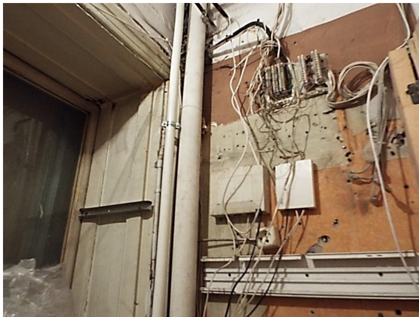
108.att. Kanalizācijas, apkures stāvvadi.
