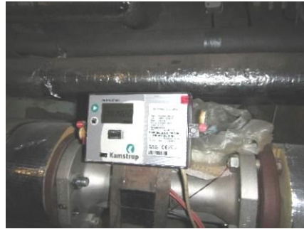
5.4.2. att. Siltumenerģijas skaitītājs.
