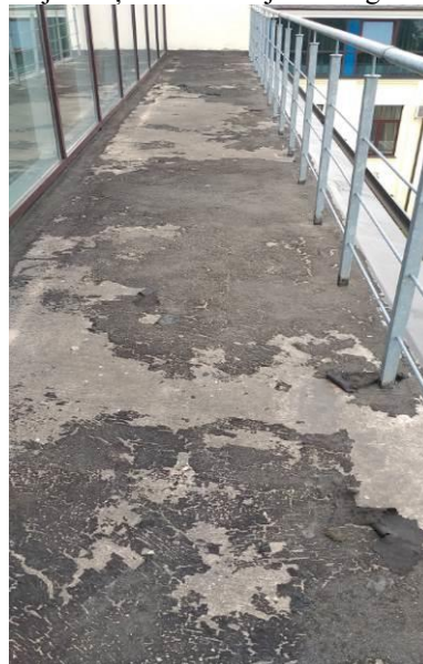
4.8.2.4., 4.8.2.5.att. Jaunizbūvētās daļas savietotā jumta segums ir pilnībā bojāts, atsegta betona kārta
