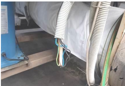
5.9.37. att. Kabelis bez otrās izolācijas kārtas
