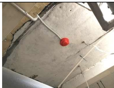
5.3.8. att. Automātiskās ugunsgrēka atklāšanas un trauksmes signalizācijas sistēmas ugunsgrēka detektors
