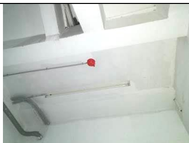
5.3.7. att. Automātiskās ugunsgrēka atklāšanas un trauksmes signalizācijas sistēmas ugunsgrēka detektors
