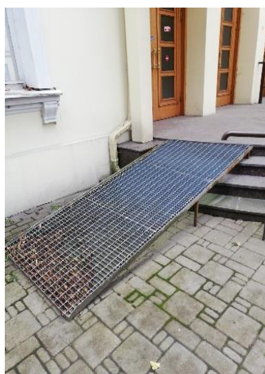
4.10.1.14.att. Panduss pie ēkas galvenās ieejas ar neatbilstošu slīpumu.
