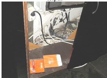
5.9.12. att. Nenostiprināti kabeļi, 1.stāva kluba telpas
