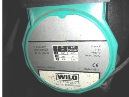
5.4.4. att. Ventilācijas apkures sistēmas cirkulācijas sūkni "WILO" TOP S50/10
