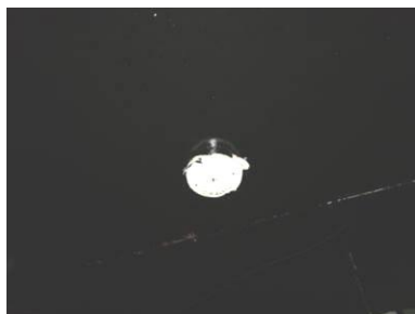
5.3.5. att. Automātiskās ugunsgrēka atklāšanas un trauksmes signalizācijas sistēmas ugunsgrēka detektors
