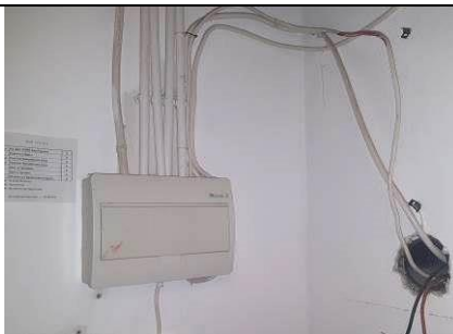
5.9.4. att. Sadalne bez brīdinājuma zīmes "Bīstami Elektrība"
