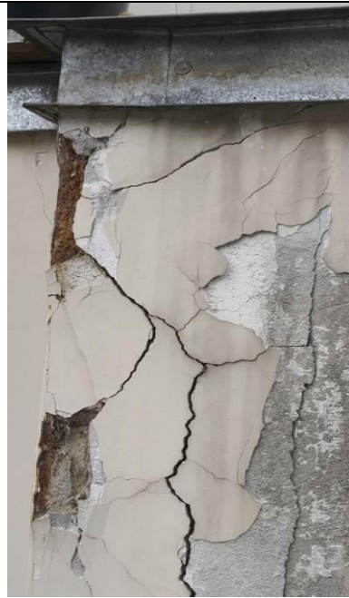
4.19.1.5., 4.19.1.6.att. fasādes apmetuma un krāsojuma bojājumi
