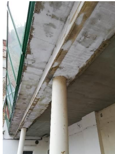
4.3.1.4.att. metāla cilindriskās kolonnas balsta pārsegumu ēkas iekšpagalmā (d=25cm). Nav pabeigta apdare.
