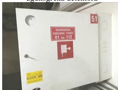
5.3.12. att. Iekšējā ugunsdzēsības ūdensvada krāna skapis
