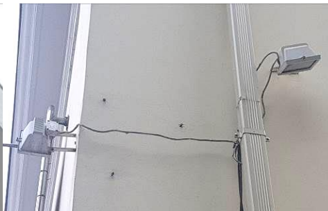
6.7.2. att. Elektroinstalācija stiprināta pie notekcaurulēm
