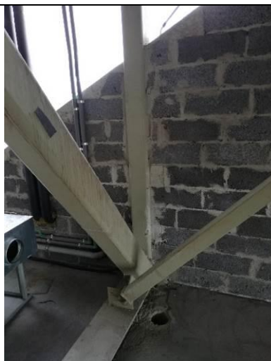
4.2.3.6.att. 4.stāva augšējais apjoms ir piebūvēts no keramzītbetona blokiem, nav veikta iekšējā apdare.
