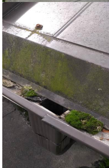
4.8.2.15., 4.8.2.16., 4.8.2.17., 4.8.2.18.att. Apsūnojis jumta segums un ar sūnām un gružiem aizsērējušas notekrenes
