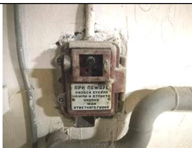
5.3.18. att. Nefunkcionējoša manuālā ugunsaisardzības sistēmas iedarbināšanas ierīce
