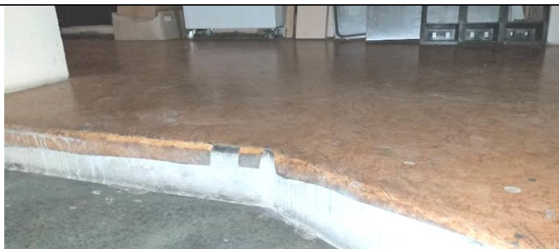
4.12.1.4.att. Nolietojies linolejs
