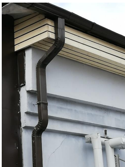
5.1.2.9. Skārda notekcaurules ar PE pārklājumu brūnā krāsā
