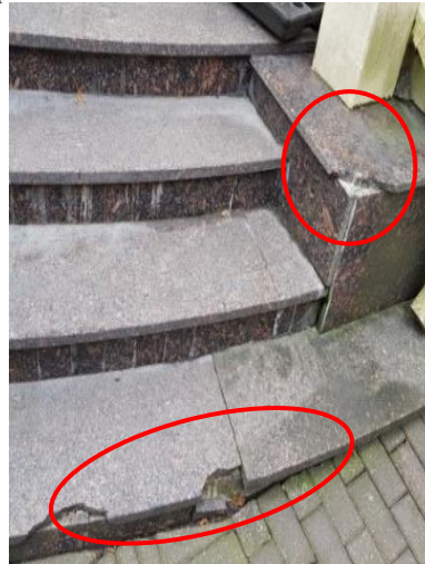
4.10.1.2.att. Galvenajām ieejas kāpnēm Nr.1 izdrupušas akmens flīzes.
