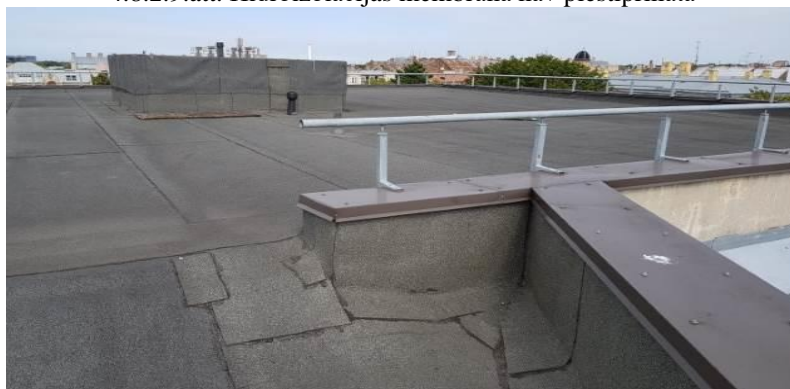
4.8.2.10.att. Savietotā jumta iesegums
