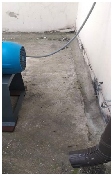
4.8.2.14.att. Lietus ūdens novadīšana uz jumta daļu, bez tālākās novadīšanas
