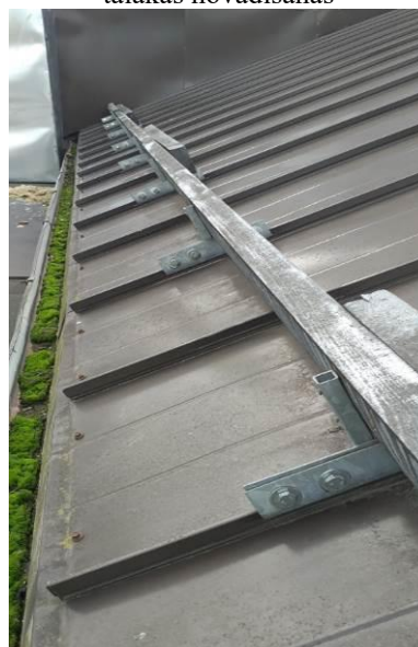
4.8.2.14.att. Lietus ūdens novadīšana uz jumta daļu, bez tālākās novadīšanas
