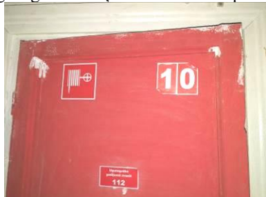
5.3.13. att. Iekšējā ugunsdzēsības ūdensvada krāna skapis
