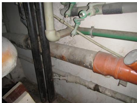
5.1.2.7.att. Savienojums ar veco čuguna kanalizācijas cauruļvadu
