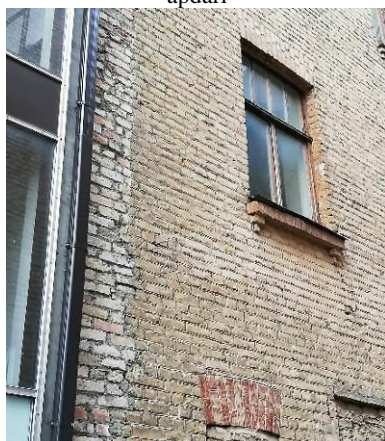
4.2.3.7.att. vecā ēkas ķieģeļu mūra ZA siena, tai klāt piebūvēta jaunā ēka.
