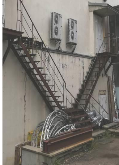
4.10.1.5.att. Metāla ārējās kāpnes Nr.4a,4b ēkas ZA pusē.
