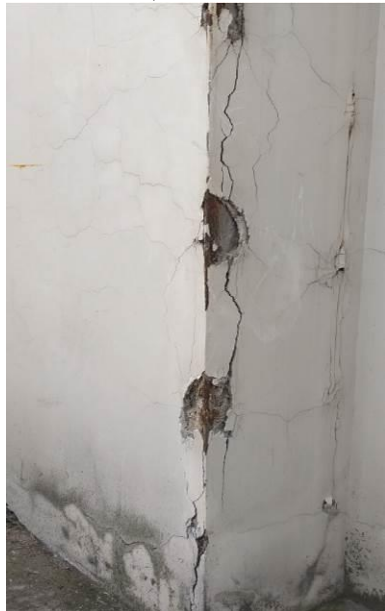
4.19.1.7., 4.19.1.8.att. fasādes apmetuma un krāsojuma bojājumi
