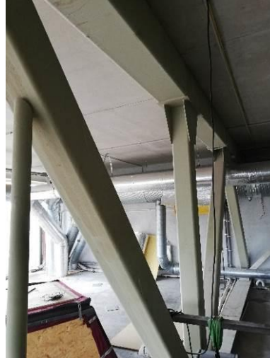
4.3.1.2.att. tērauda kopnes no jauna izbūvētajā jumta stāva apjomā.
