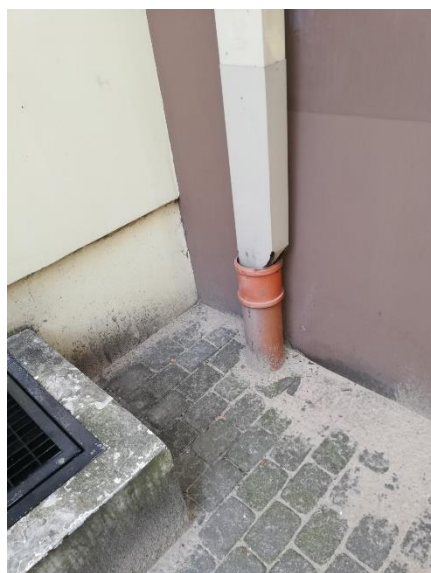
5.1.2.10. Notekcaurule ar tiešo pieslēgumu kanalizācijas sistēmai
