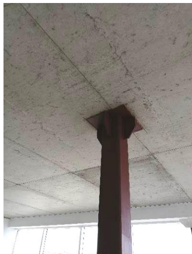
4.3.1.3.att. ieejas mezgla metāla kvadrātveida kolonnas balsta ieejas mezgla jumtu.
