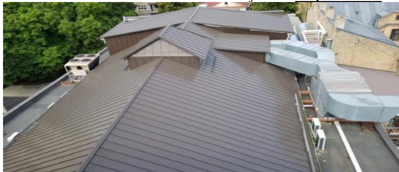
4.8.2.1.att. Skats uz galvenās ēkas jumta segumu
