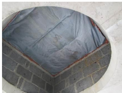
4.16.2. att. Viens no diviem lielajiem dabīgās ventilācijas gaisa kanāliem virs zālēm ir demontēts un aizdarīts.
