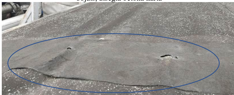
4.8.2.6.att. Savietotā jumta segums nekvalitatīvi ieklāts un ar vizuāli redzamiem bojājumiem, nav hermētiskums
