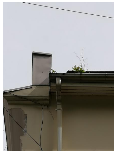
5.1.2.14. Skārda notekcaurules ar PE pārklājumu
