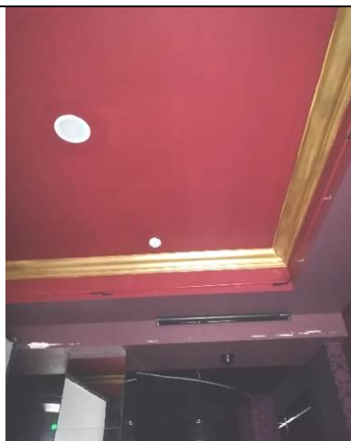
4.6.2.1.att. Griesti ieejas vestibilā. Bez atsegšanas pārseguma konstrukcija vizuāli nav apskatāma
