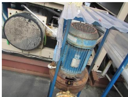
5.6.8. att. Dzesēšanas sistēmas cirkulācijas sūknis "Lowara".
