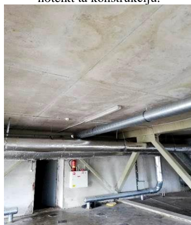
4.6.2.4.att. Monolīta dzelzsbetona pārsegumi
